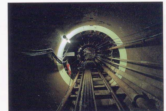
推進工法からシールド工法への工法転換地点
