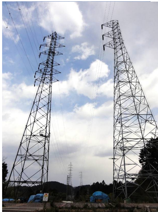
(左) 新設鉄塔 (右) 仮設鉄塔
