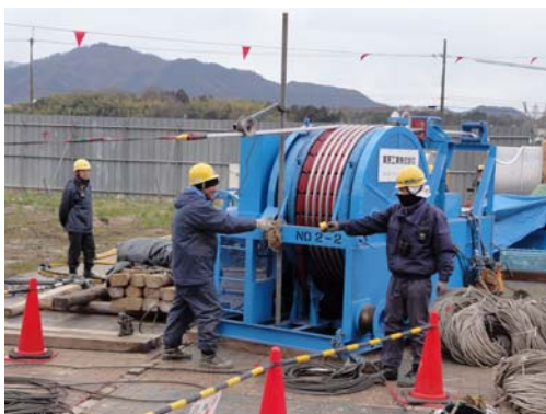
架線の送り出し作業
