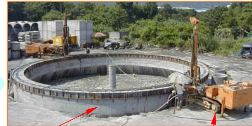
刃口ブロック(現場打ちRC構造)アースアンカー削孔中
